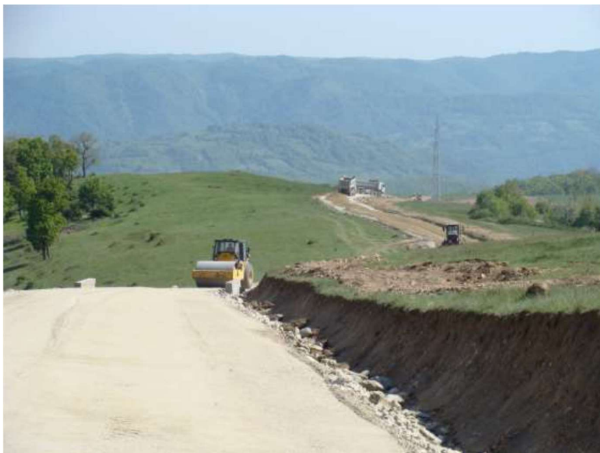
Fig 8 Lucrări de amenajare a unui drum tehnologic pentru un parc eolian Se observă structura convexă a profilului transversal și modalitatea de construire a rigolelor cu anrocamente în scopul atenuării forței erozive a apelor pluviale
