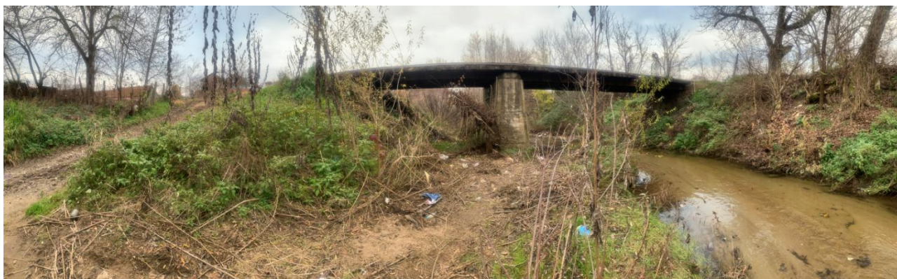
Vedere laterală amonte, din albia râului Tău
