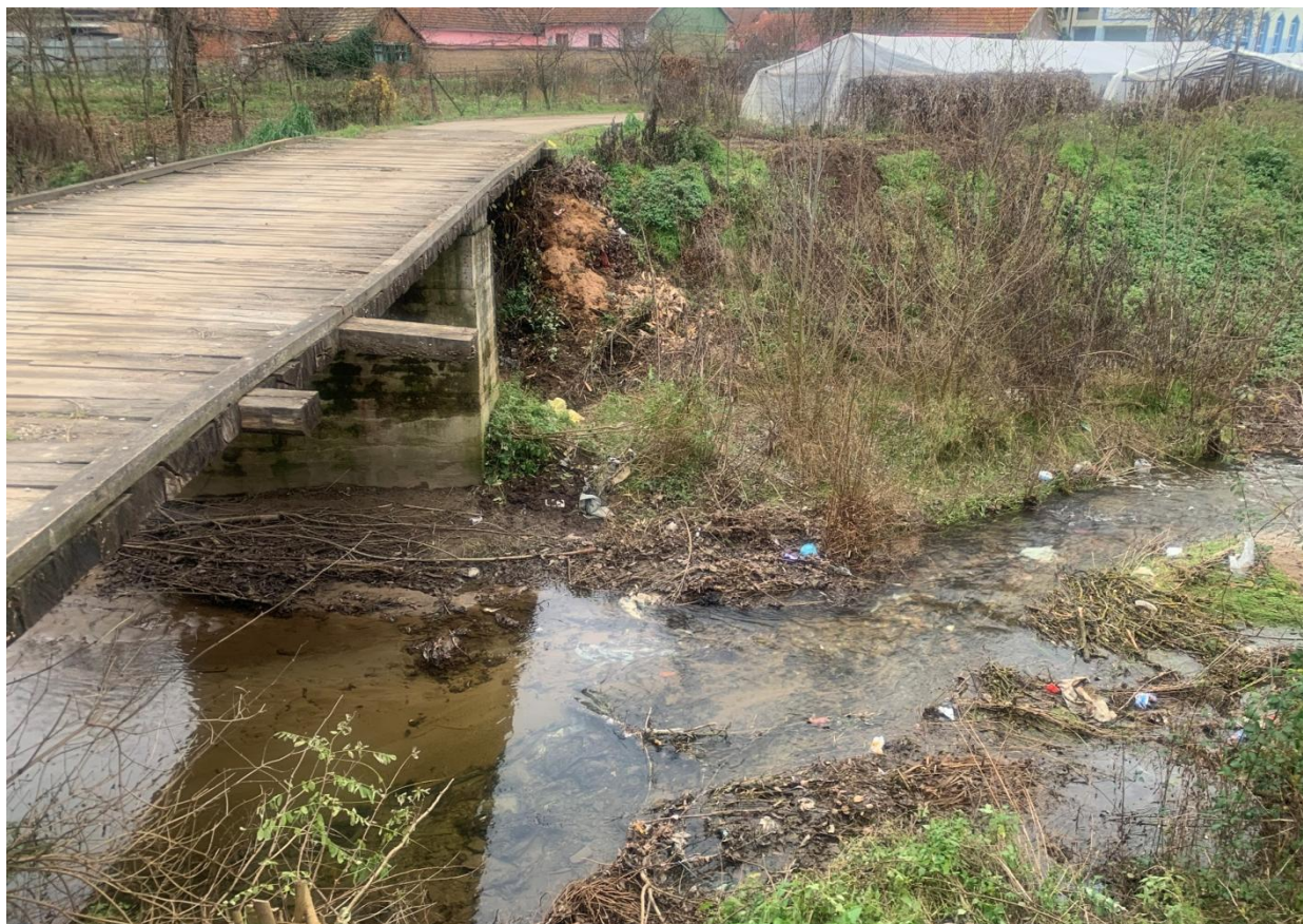
Vedere aval, de pe malul drept al râului Tău
