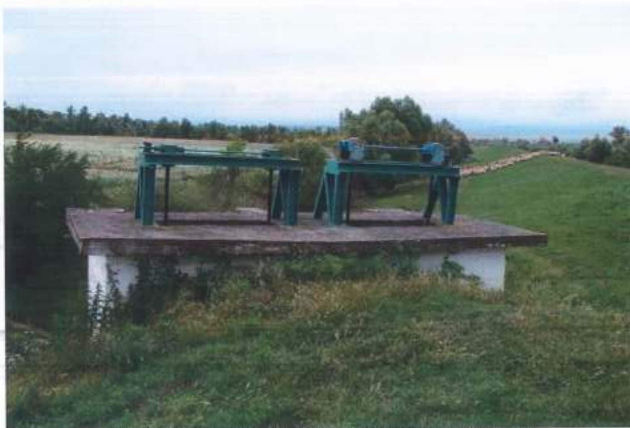
Figura 13 – Uzură fizică și morală a sistemelor de acționare aferente golirilor de fund
