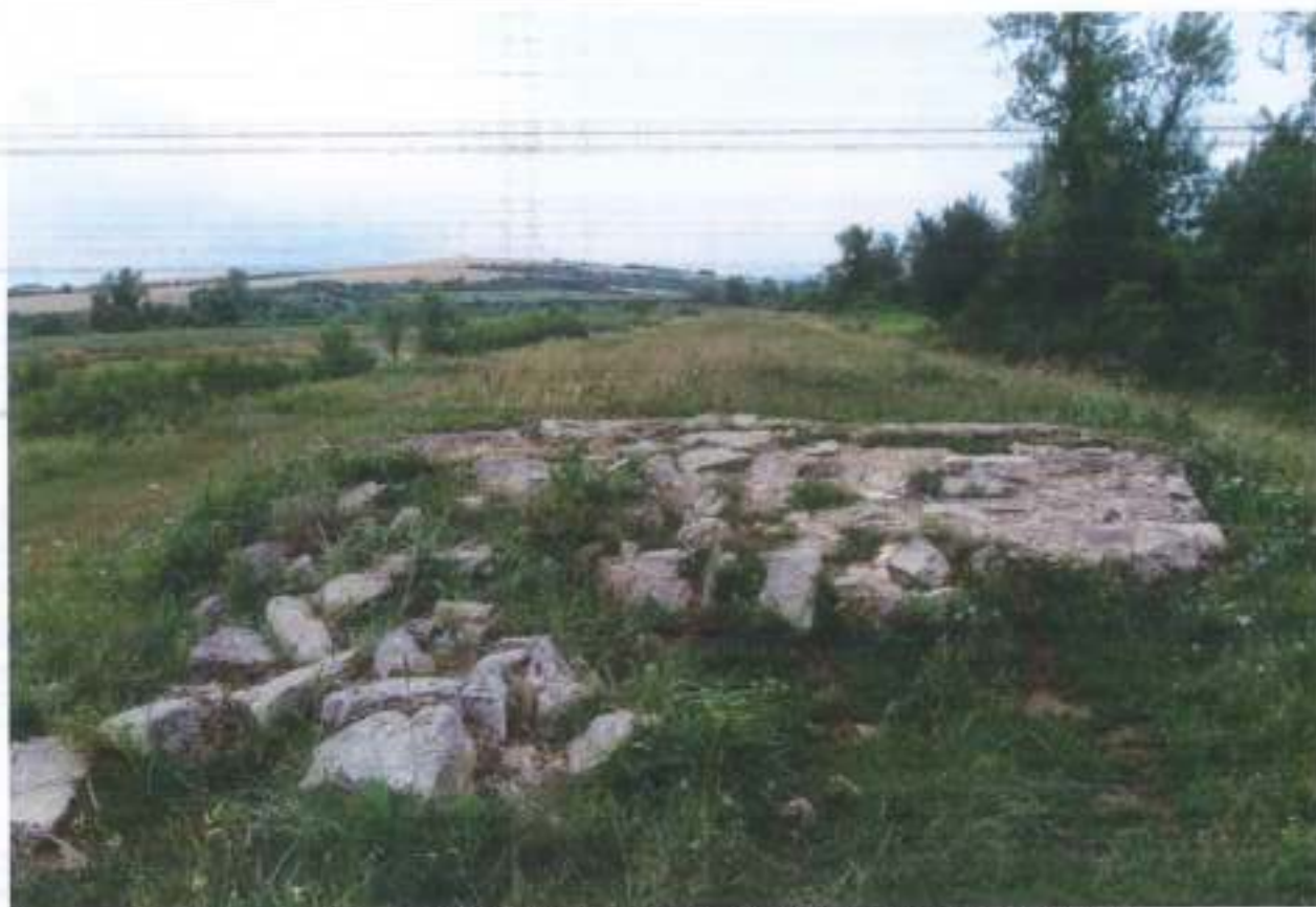
Figura 22 -Lipsa mirelor hidrotehnice și a repererilor nivelitici pe coronamentul digurilor
