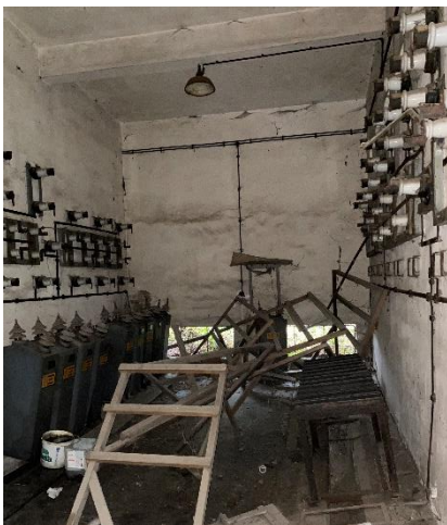
Foto 1, foto 2, foto 3, foto 4, foto 5, foto 6, foto 7, foto 8, foto 9 – construcția 35580-C1 – clădire transformator 6kV – percepție de ansamblu și starea de degradare aferentă
