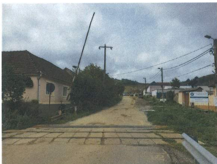
Figura 3.6.1-9 Starea actuală a căii
