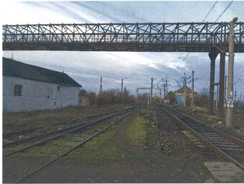
Figura 3.6.1-18 Pasarelă pietonală metalică
