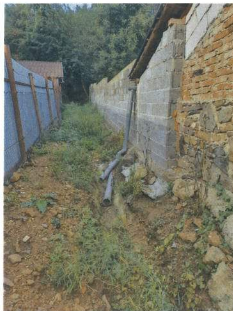
Figura 3.6.1-16 Starea actuală a podețelor de cale ferată
