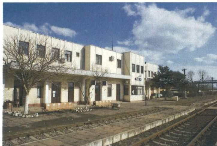
Figura 3.6.1-10 Starea actuală a clădirilor de cale ferată
