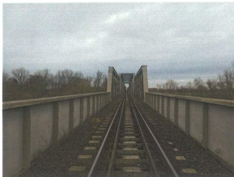
Figura 3.6.1-23 Pod peste râul Timiș
