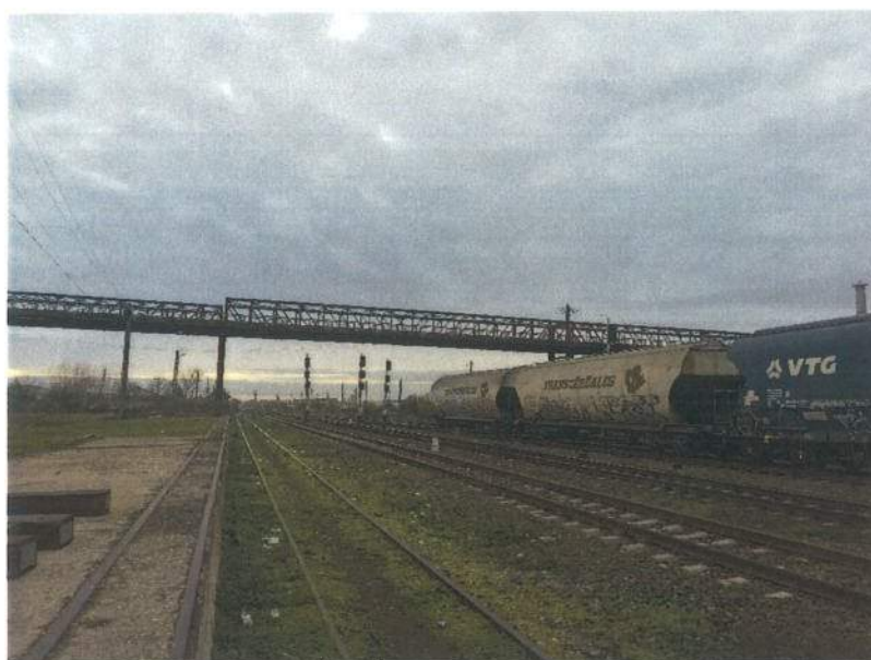
Figura 3.6.1-20 Pasarelă pietonală metalică
