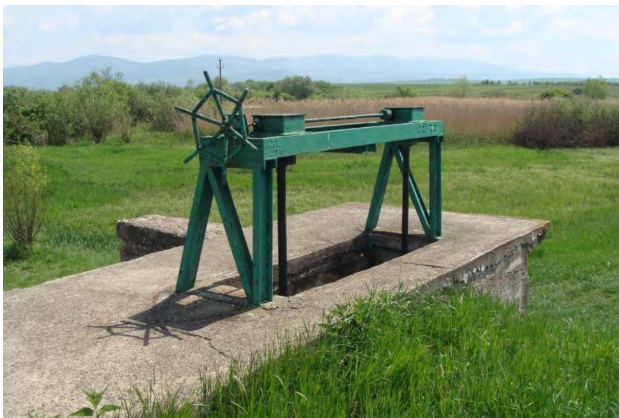
Figura 4 - Mecanismul de acționare aferent stăvilărilor principal de golire- uzat fizic și moral după 35 de ani de exploatare
