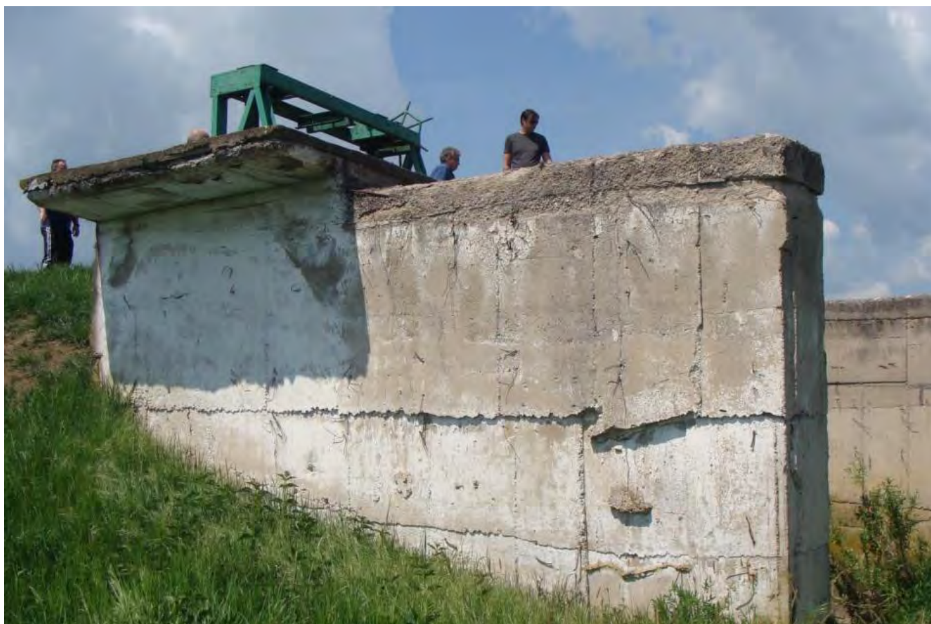
Figura 9 – Lipsa mirelor hidrometrice pentru determinarea volumelor atenuate în incinta polderului, respectiv a debitelor evacuate
