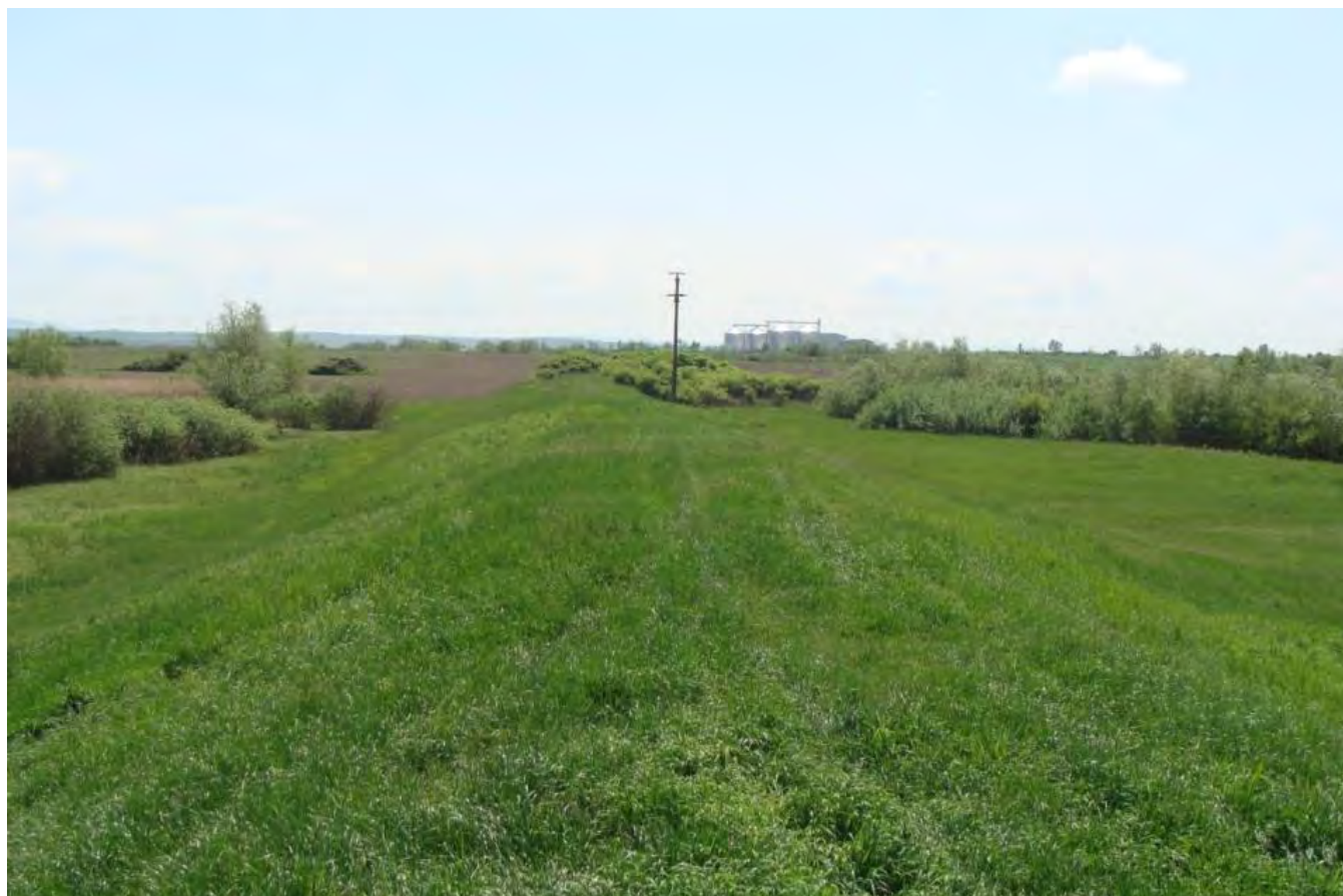
Figura 10 – Lipsa reperilor de nivelment pentru monitorizarea tasărilor construcției
