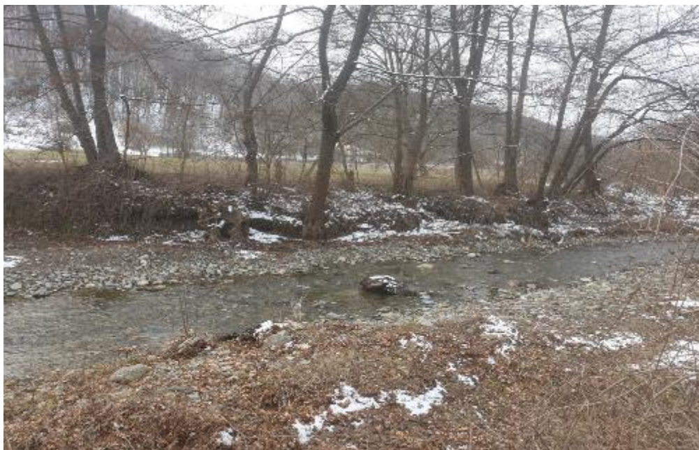
Figura nr.5.2.-7 Imagini cu zona de subtraversare a paraului Cosustea Mica
