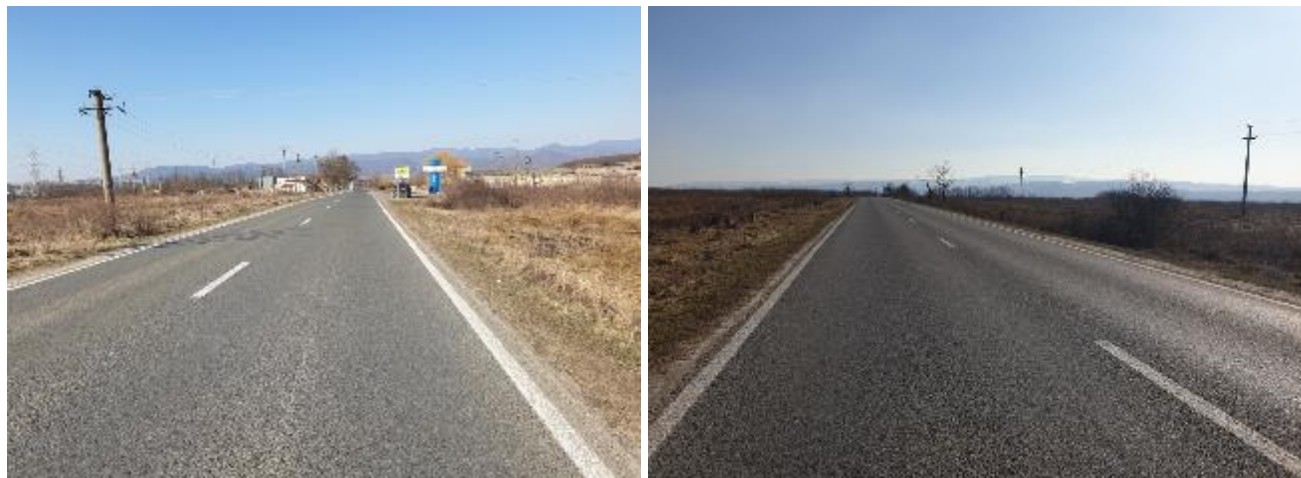
Foto29,30: Zonă Subtraversare DN68 – loc. Iaz – km 176, UAT Obreja, județul Caraș Severin
