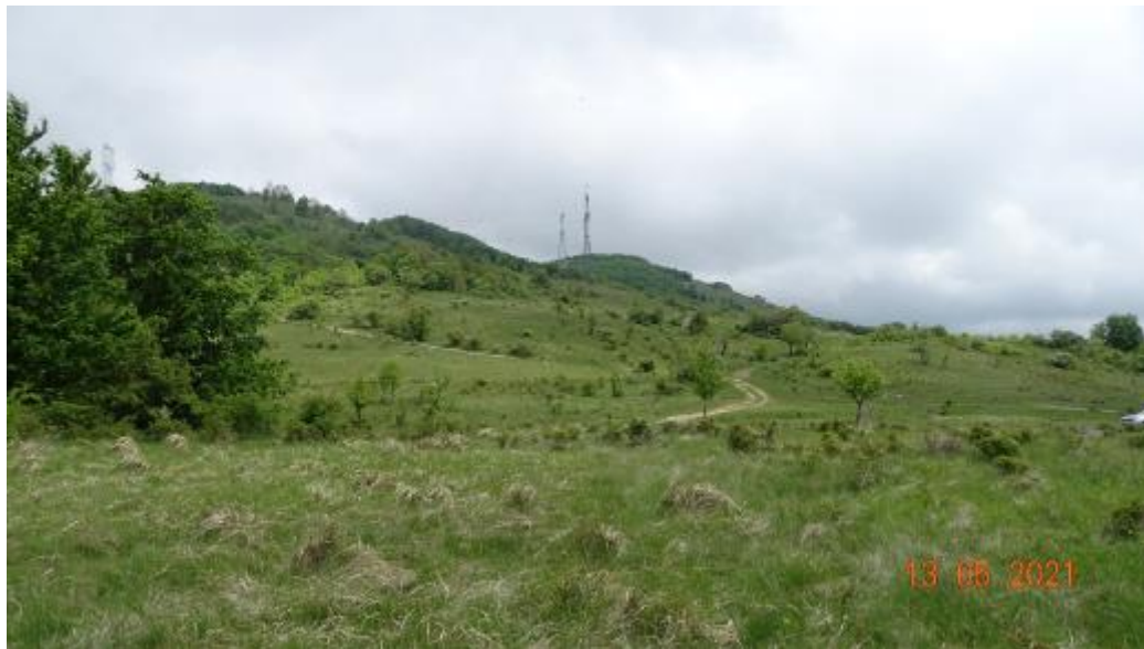
Figura nr.5.2.-11 Aspect amplasament zona de lucrări km 73
