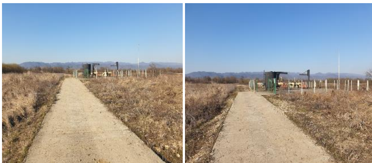
Foto31: Locație punct final conductă – km 177, UAT Obreja, județul Caraș Severin
