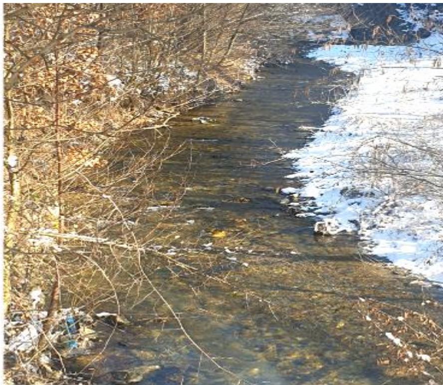
Figura nr.5.2-9 Imagine cu zona de subtraversare a pârâului Bahna
