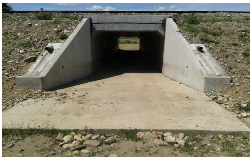
Figura 11. Exemplu de podeț alcătuit din elemente prefabricate
