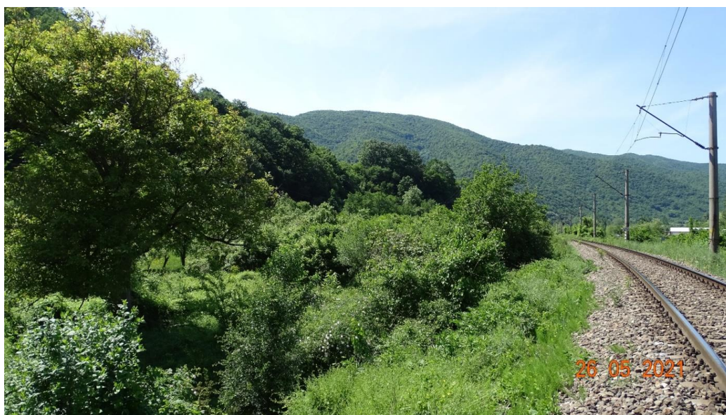
Figura 2.5-18 Aspect al amplasamentului traversat prin foraj orizontal
