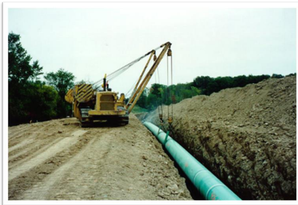
Figura 1.3.1.2.2-2 Prezentare a modul de lansare a unei conductei de transport gaze naturale în șanț
