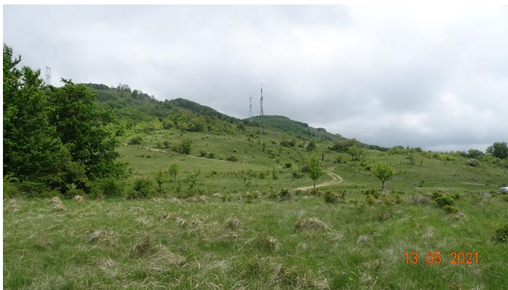
Figura nr. 2.5-11 Aspect amplasament zona de lucrări km 73
