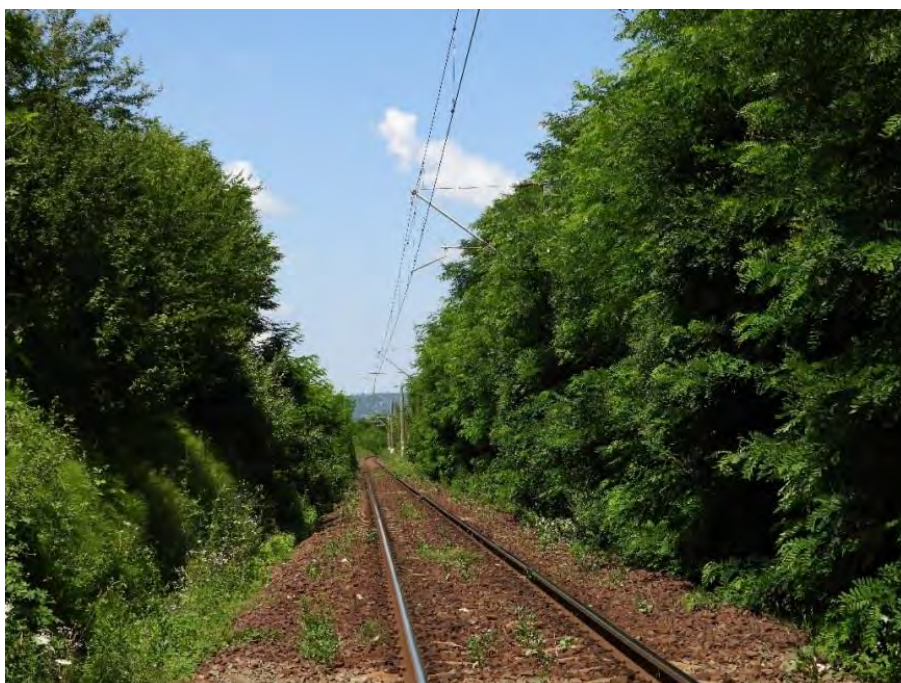
Foto 27. Aspectul amplasamentului stației 19
