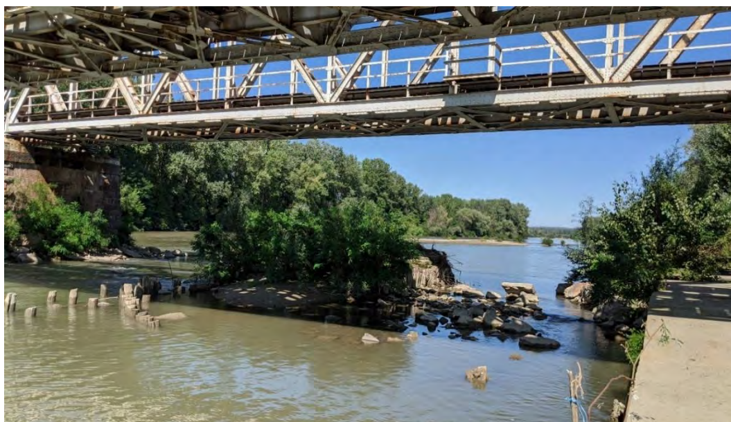
Foto 82. Aspectul râului Jiu la km 291+000
