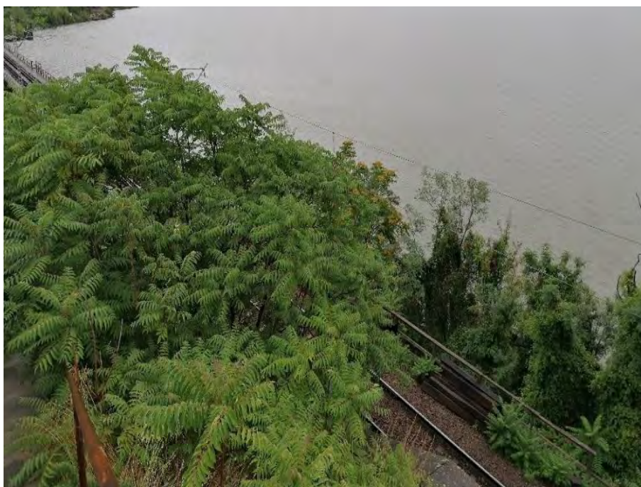
Foto 21. Aspect general al vegetației
