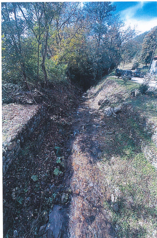
Figura 3 – Consolidări de mal din gabioane și din zidărie de piatră mal stâng și mal drept (vedere din amonte în aval)
