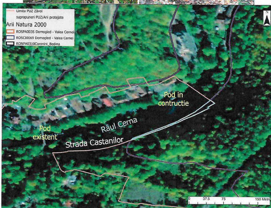
Amplasamentul zonei 3 strada Castanilor, utilități în zona (pod in construcție, aducțiune apă prin amplasamentul zona 3, rețele de comunicații prin cablu)
