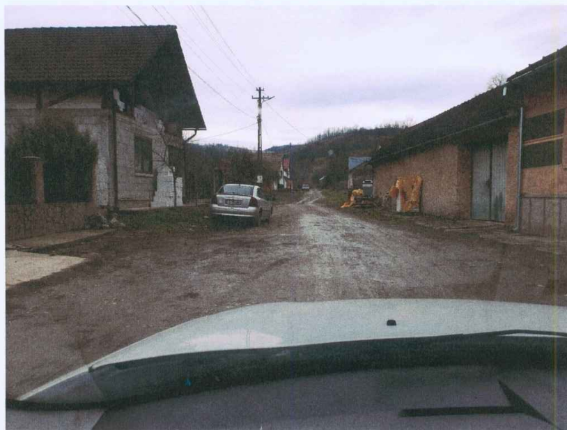
Img. 3. Strada Vale (Goruiă), km 0+200 - situația existentă
