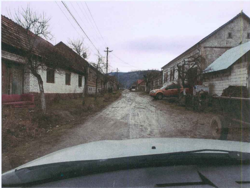
Img. 1. Strada Vale (Goruia), km 0 - situația existentă
