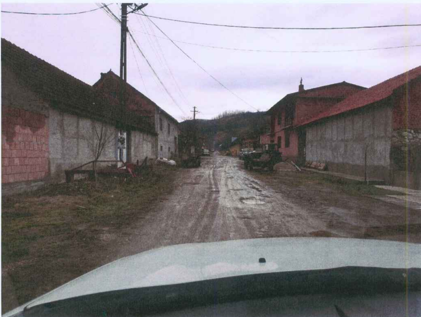
Img. 2. Strada Vale (Goruia), km 0+100 - situația existentă
