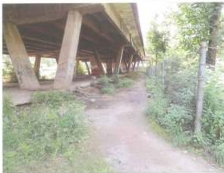
Stradă de legătură – subtraversare pasaj Intim
