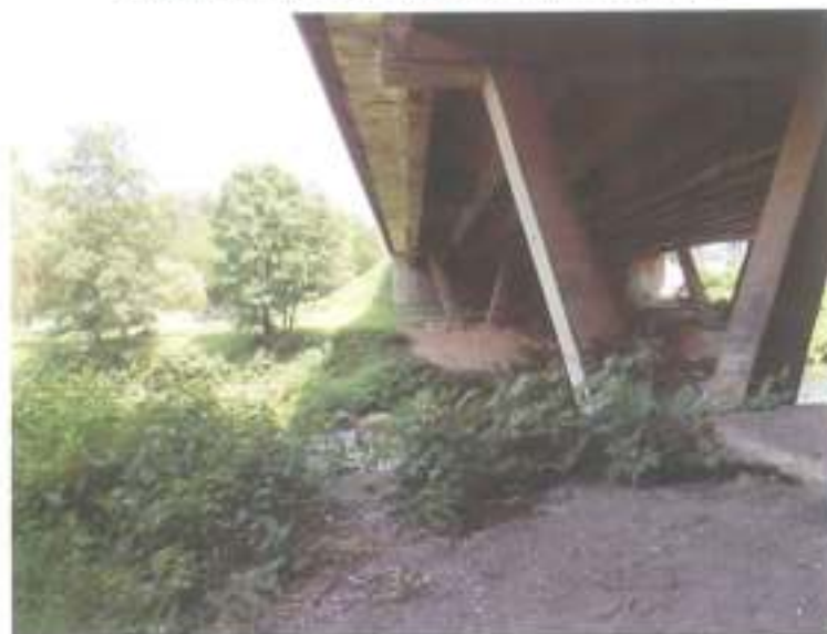
Stradă de legătură – subtraversare pasaj Intim
