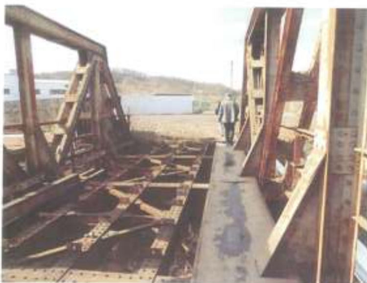
Podul metalic – se va demola – amplasament pod nou km 0+024
