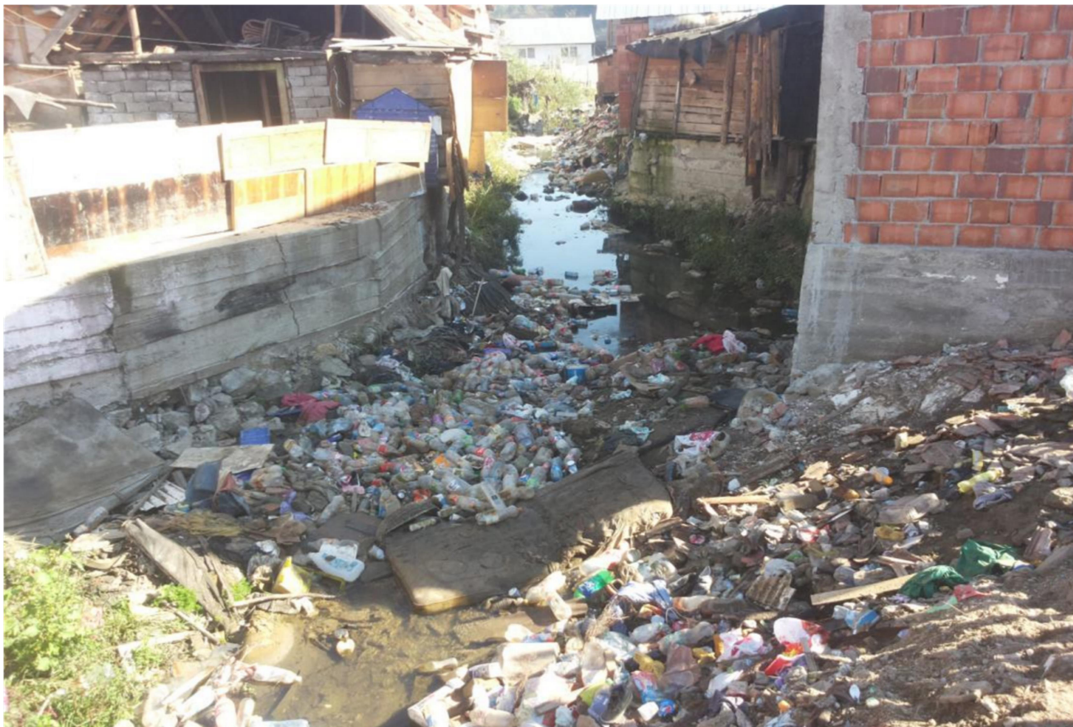
Figura 2. Depozitarea în albie de deșuri și fundarea caselor în albie
