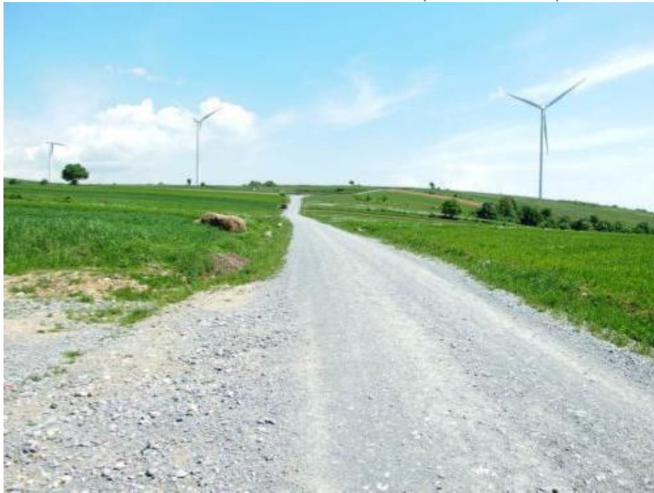
Figura nr. 15 Imagine ce infatiseaza suprafete de terenuri agricole din amplasamentul parcului eolian – dreapta si stanga drumului de acces catre clusterul de turbine T1 – T7 (mai 2015)
